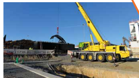
Die TRUCKBAY wird an einem Stück mittels Kran an ihren Bestimmungsort gehoben.
