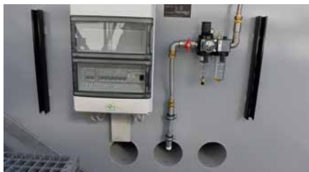
Alle erforderlichen Versorgungsleitungen werden verlegt und angeschlossen.
