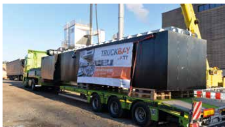
Anlieferung der TRUCKBAY-Fertigrube zum Projektort
