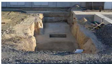
Die Sohlplatte wird bauseitig nach Vorgabe betoniert.
