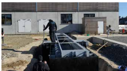
TRUCKBAY wird ausnivelliert vor dem Vergießen.
