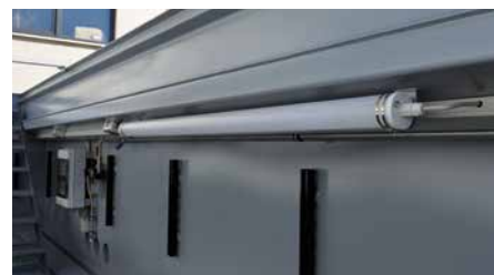
LED-Rohrleuchte, 1630 mm lang, 3800 lm
